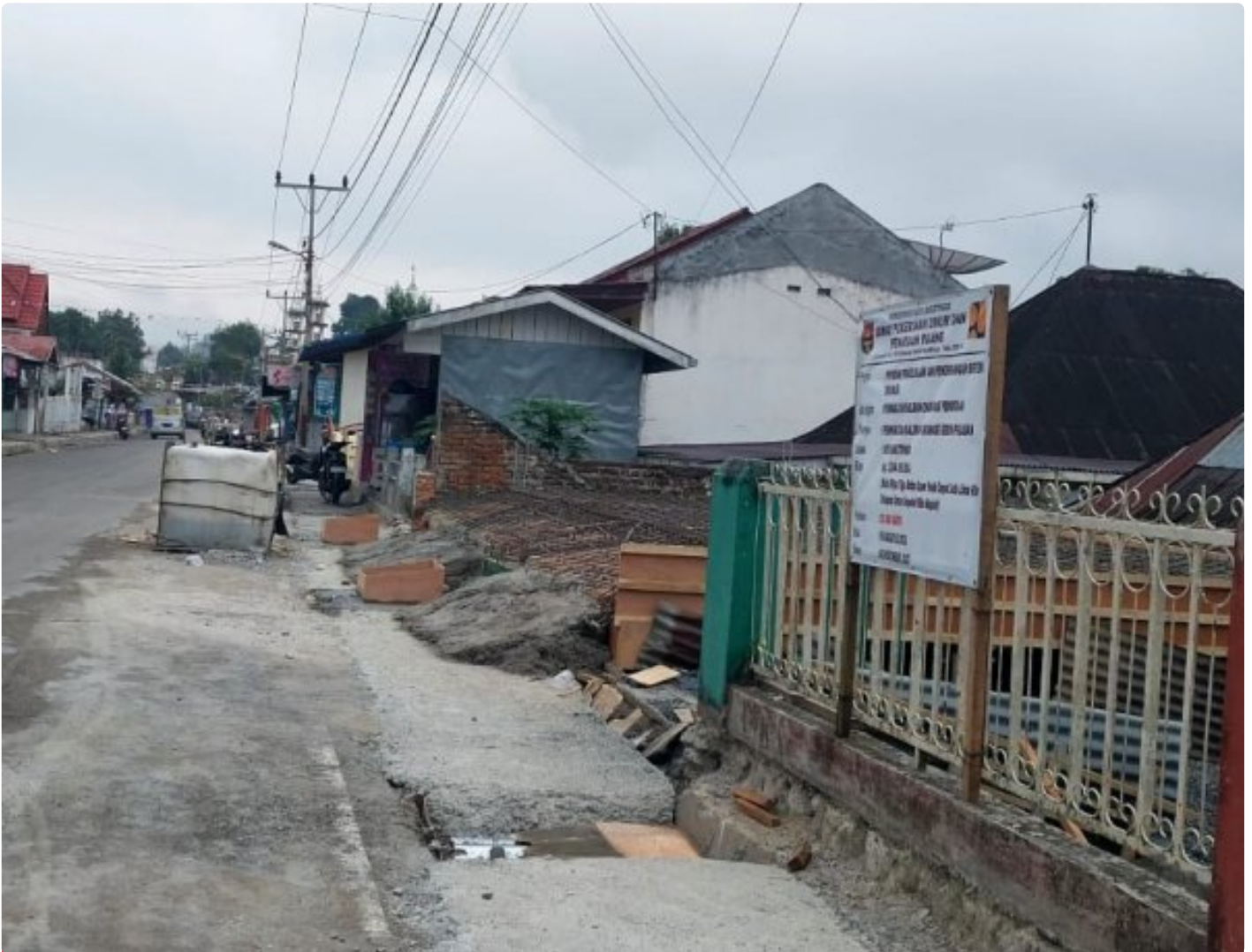
Proyek Drainase Kabun Pulasan Kota Bukittinggi bobot baru sekitar 25 % pengerjaannya
